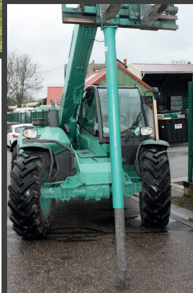
Führung zum Einrammen der PVC-Pfähle
