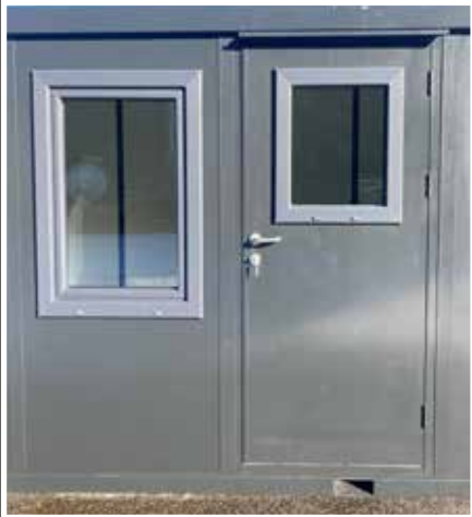
Abschließbare Tür (84 x 189 Cm) mit integriertem Fenster (44 x 52 Cm)
